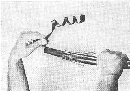
mit abziehbarer äusserer Leitschicht, die in einem Arbeitsgang mit der Leiterglattschicht und der Isolation aufgespritzt wird, eine Weiterentwicklung von *Câbles Cortailod S.A.*, 2016 Cortailod, bringt entscheidende Verbesserungen mit sich:
