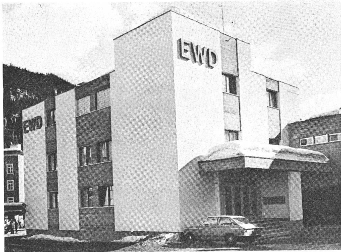
Fig. 1 Verwaltungsgebäude in Davos-Platz
