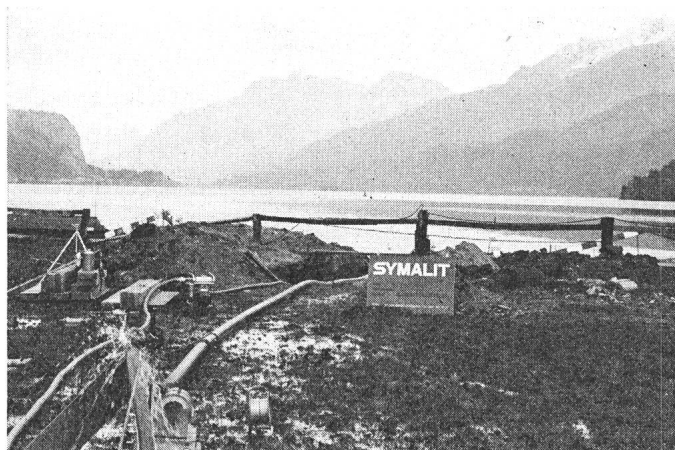
Fig. 14 Bau einer Kabelleitung durch den Silsersee
