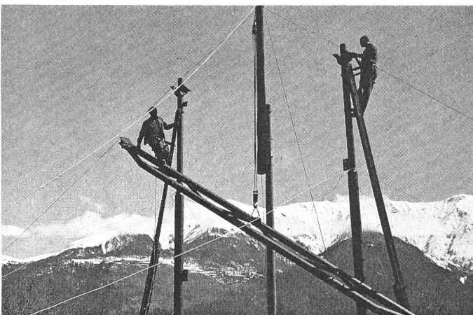
Fig. 8 Bau eines Abspannmastes am Heinzenberg
