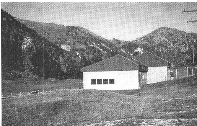
Fig. 7 Unterstation Rüti bei Splügen
