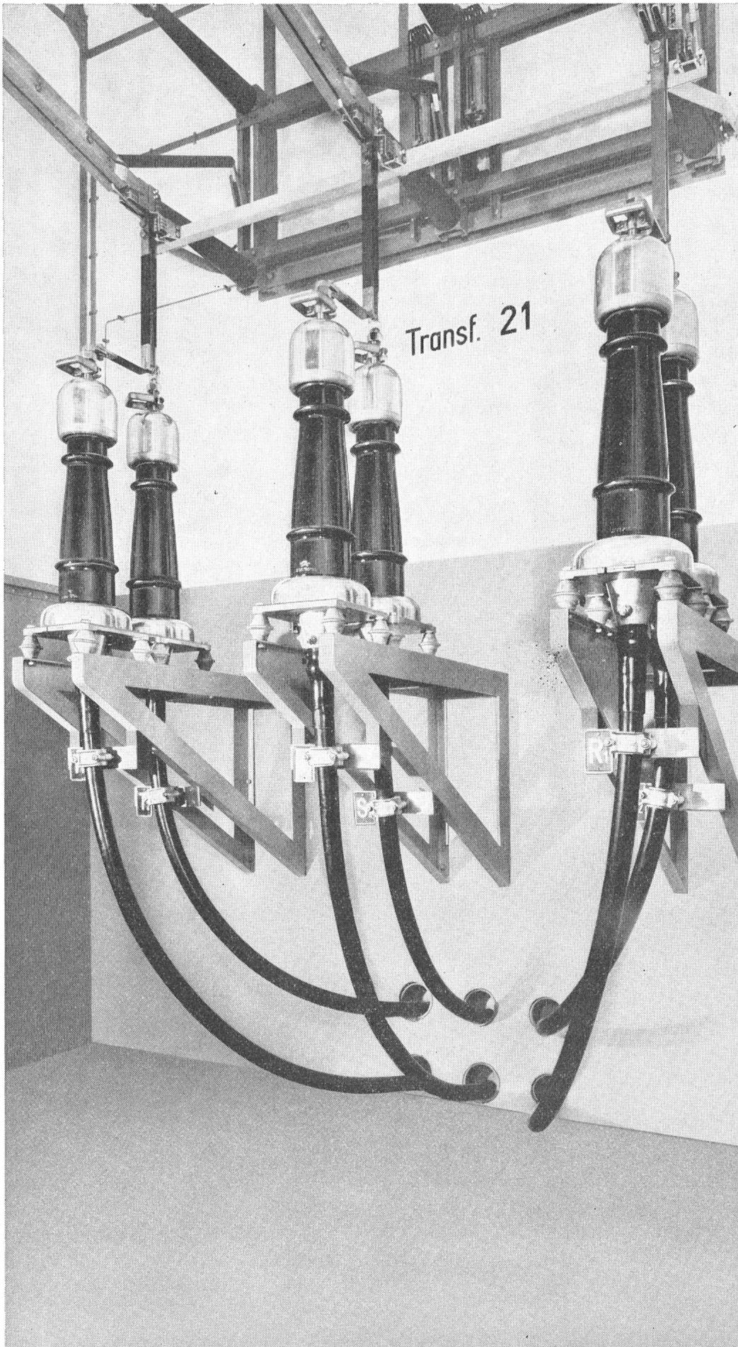
60 kV Einleiter-Ölkabel 1x800 mm<sup>2</sup> mit Innenraum-Kabelendverschlüssen als Verbindungsleitung zwischen Schaltanlage und Transformator in einem Unterwerk 220/60 kV
