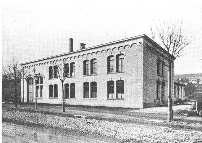
Fig. 3 Ehemaliges Depot der Industriequartier-Strassenbahn an der Hardturmstrasse; Geschäftshaus der TP von 1904 bis 1921
