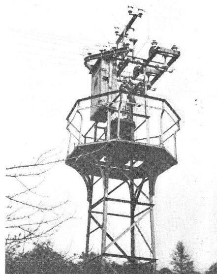
Fig. 1 Ein Inspektionsobjekt in der guten alten Zeit
