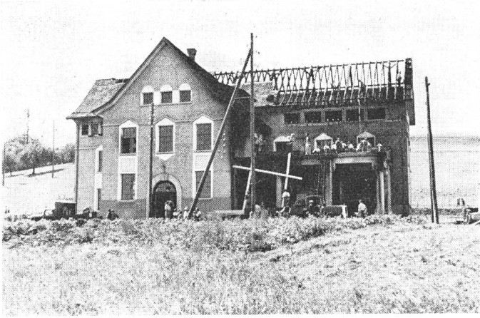
Fig. 1 Unterwerk Aathal nach dem Brand
