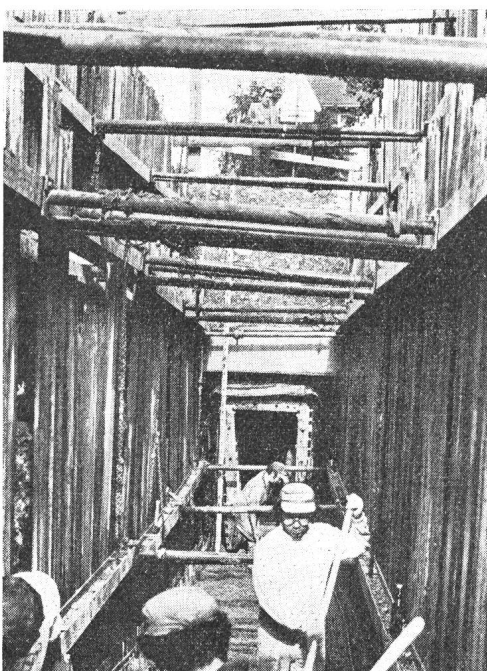
Fig. 22 Bau des Kabelstollens für ein zweisträngiges 220-kV-Kabel
