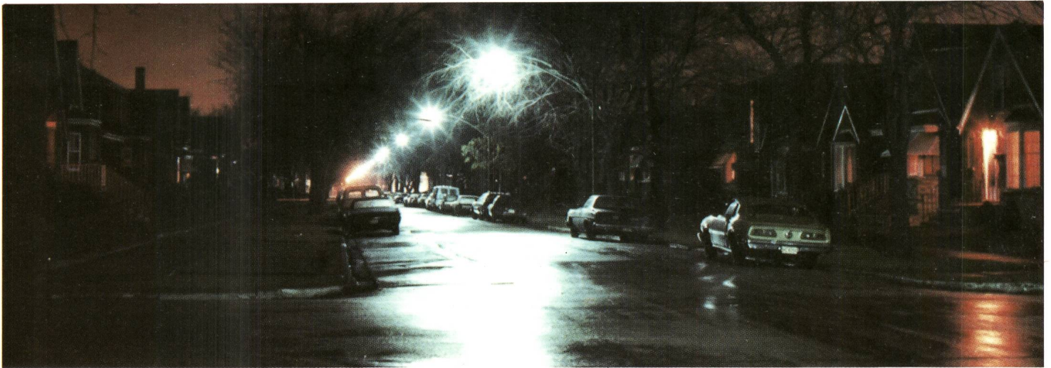
Wohnstraßenbeleuchtung mit herkömmlichen Quecksilberdampflampen.
