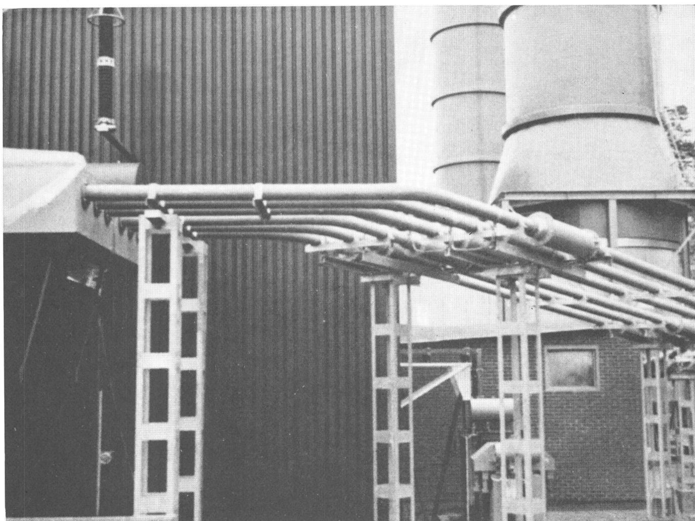
**Vollisolierte Generatorausleitungen 17,5 kV 4,8 kA
