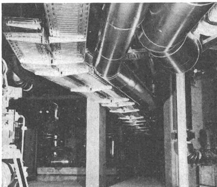
patentierten, schraublosen Stossverbinder. Stossleisten verhindern Niveauunterschiede im Bodenblech und schützen vor Beschädigungen der Isolierung beim Kabelziehen. Für Richtungsänderungen (Horizontal- oder Vertikalbogen, Abgänge, Kreuzungen) gibt es fertige Formteile.
