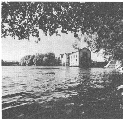
Fig.1 Ein Kraftwerk aus den Gründerjahren: Ruppoldingen oberhalb von Aarburg
