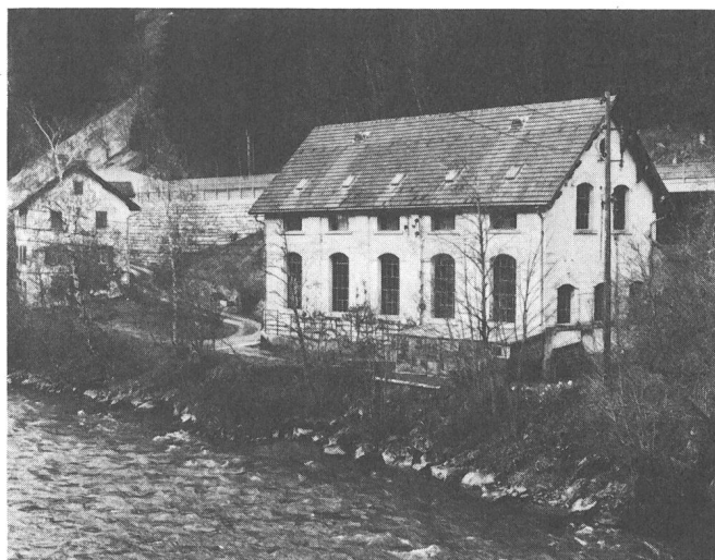
Erstes Maschinenhaus des Kraftwerks Waltensburg (erbaut 1907)
