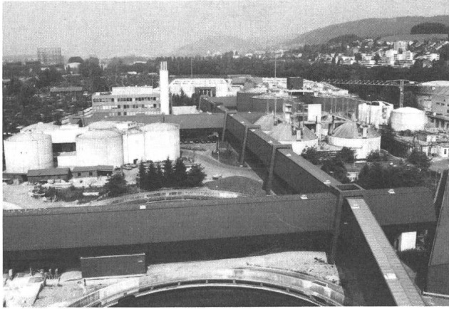
Fig. 1 Die Baustelle Werdhölzli
