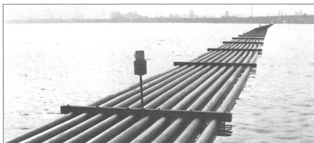
Der Rohrblock mit Briden wird abgesenkt.
