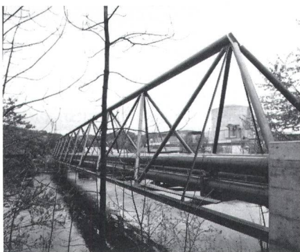
Fig. 11 Beidseits vom neuen Fussgängersteg sind die Vorlauf- und Rücklaufleitungen für die Fernwärme montiert.
