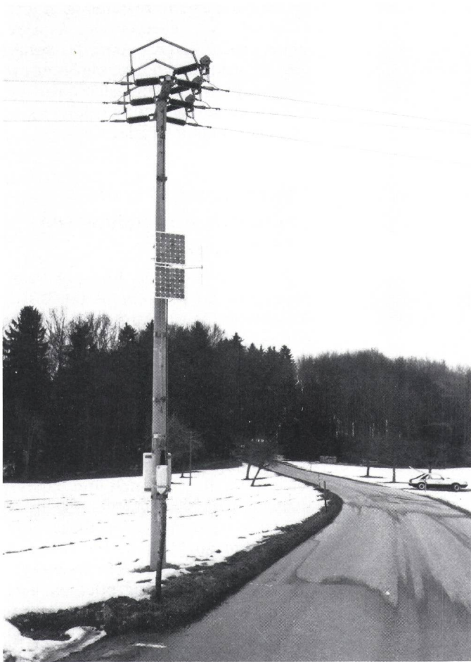
Fig. 3 Photozellen dienen zur Speisung der Batterie zur fern-gesteuerten Trennschalters einer Freileitung (Photo: EEF)
