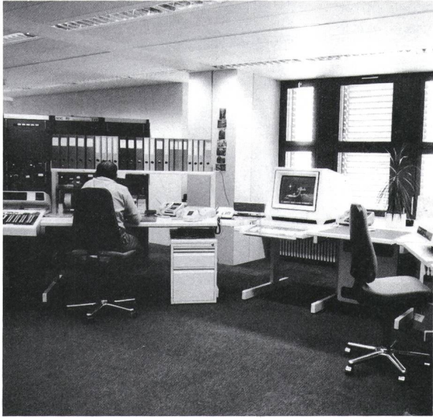
Fig. 2 Überwachungszentrale mit Arbeitsplätzen für Gebäude- und Netzleitsystem
