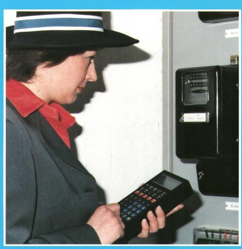
Elektronische Zählerablesung Relevé électronique des compteurs
