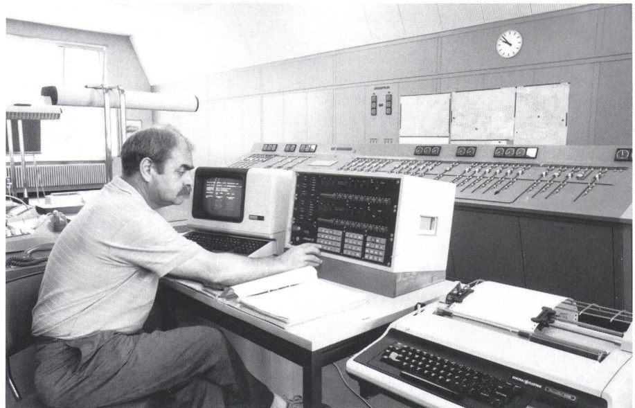
Fig. 5 Zentrale Neuhausen mit Lastführungs-Sichtgerät, Bedieneinheit und Protokolldrucker
