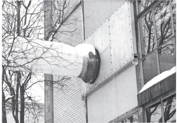
Fig. 6 Einführung eines 800-kV-Kapselungs- rohres in ein Gebäude
