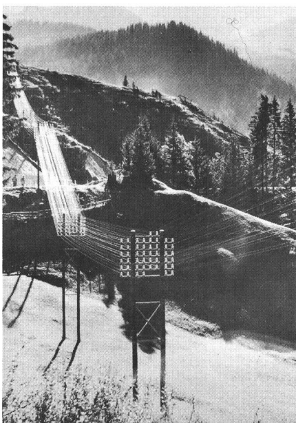
Figur 5 Doppeldrahtleitung
