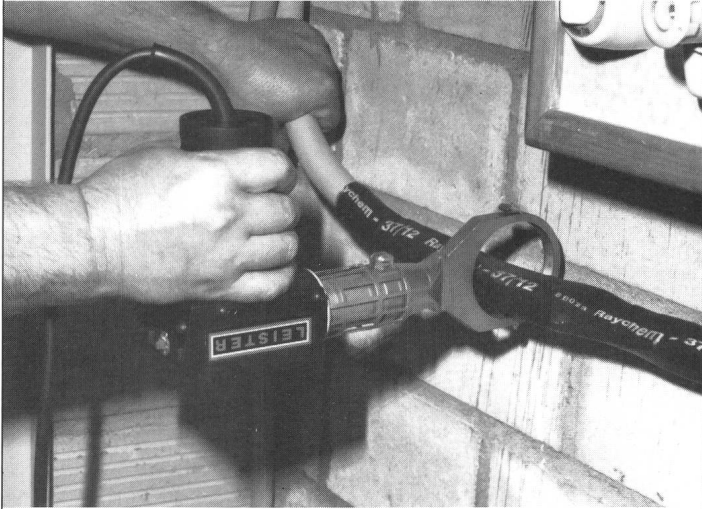
Aufschumpfen von Kabelmuffen mit dem Leister-Ghibli und aufgeschobenem Klappreflektor.
