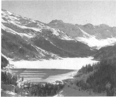
Stausee Marmorera des Elektrizitätswerkes der Stadt Zürich (EWZ)
