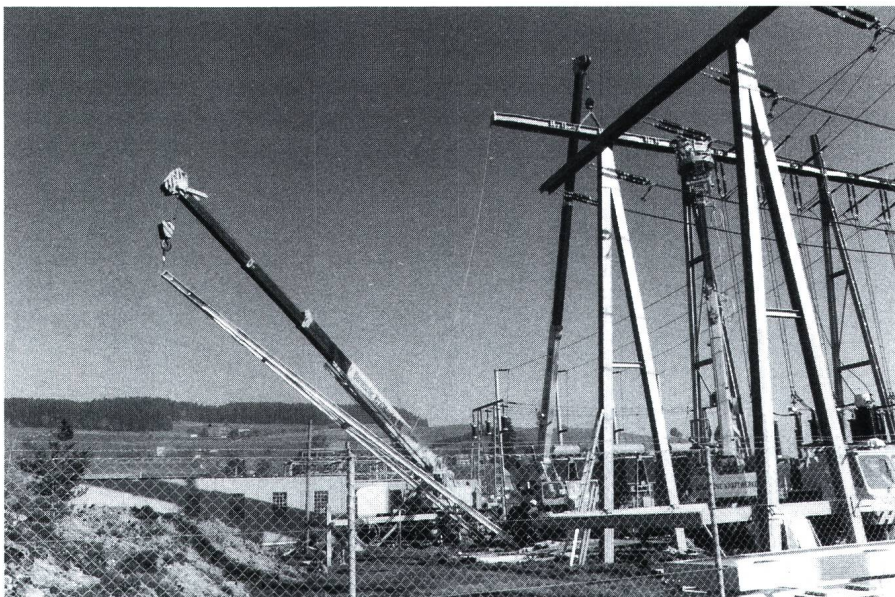
Figur 4 Mobilkran TM 550 beim Aufstellen eines Abspannportals in einer 220-KV-Anlage
