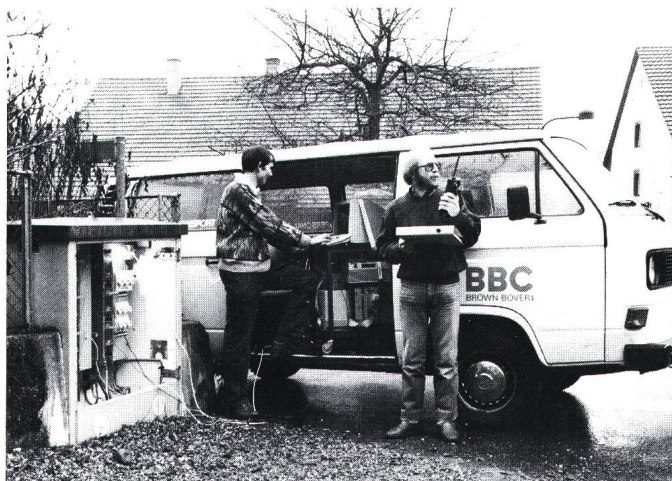
Figur 9 Messungen in einem 220-V-Netz. Fahrbare Messstation
