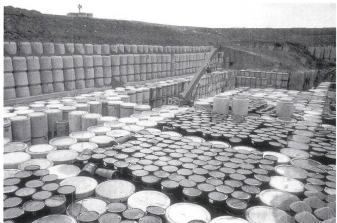
Figur 5 Das seit 1969 bestehende Endlager «Centre de la Manche» für schwach- und mittelaktive Abfälle
