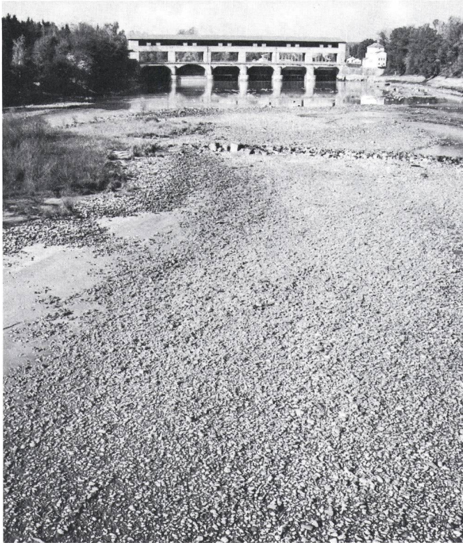
Figur 1 Weitgehender Wasserentzug – ein Kennzeichen älterer Ausleitungskraftwer- ke. Das Bild zeigt den Inn unterhalb des Jettenbacher Wehres (Ausleitung zum Kraftwerk Töging)
