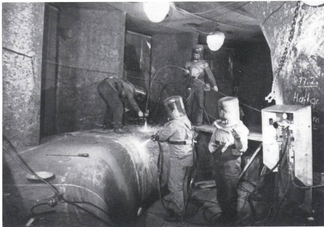
Figur 2 Panzerung durch Materialauftrag am Leitradring einer Kaplan-turbine der Staufstufe Braunau Simbach in Österreich. (Bild: Metco Schweiz AG)
