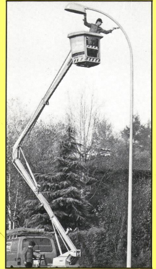
Korrosionsschutz an Stahlkandelabern
