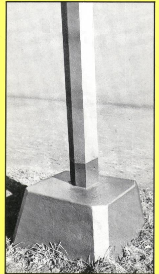
Betonsschutz an Mastsockeln
