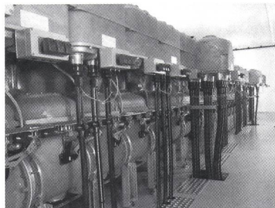
Innenkonus-Kabelstecker der Sefag AG Mal- ters, angeschlossen an metallgekapselte SF 6 - isolierte 24-kV-Mittelspannungsschaltanlage.
