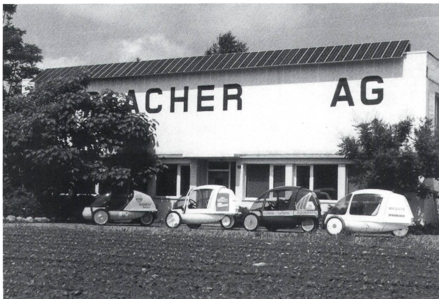
Figur 2 Das Flachdach einer Fabrik (Horlocher AG, Möhlin) wird durch den PV-Generator vorteilhaft ergänzt; die Fassade wirkt weniger streng. Die Anlage wird für die Batterieladung der abgebildeten Elektromobile und für die Netzzurückspeisung verwendet.
