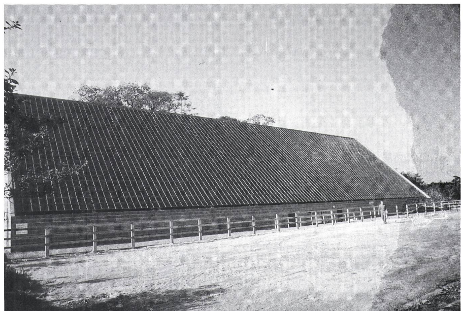
Figur 3 Ein 50-kW-Generator auf Fota Island, Irland. Er ist als «Kaltdach» direkt auf die Dachlattung aufgesetzt. Das Gebäude gehört zu einer Milchfarm mit 250 Kühen der Universität Cork und versorgt diese autark über einen Bleiakкумуляtor-Speicher mit elektrischer Energie. Photo: AEG-Olympia, Hamburg
