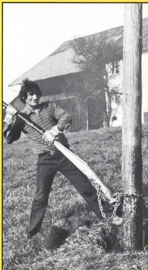
Nachimprägnierung von Holzmasten
