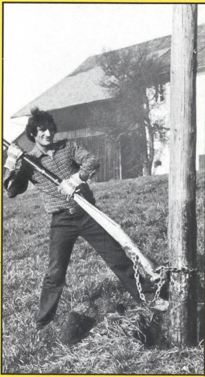
Nachimprägnierung von Holzmasten
