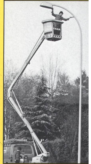
Korrosionsschutz an Stahlkandelabern
