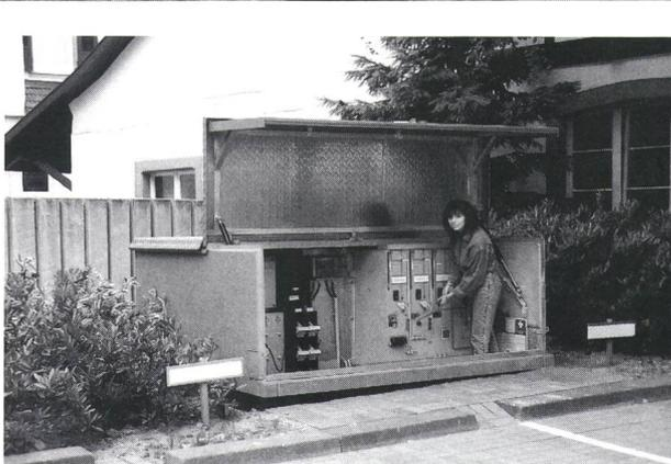
Die Mono 2 ist wegen ihrer niedrigen Bauhöhe zur Aufstellung in Vorgärten, Parkanlagen, Grünstreifen und an Strassenkreuzungen die perfekte Lösung. Einböschungen sind möglich. Die Schwellenhöhe an der Frontseite beträgt 0,20 m.
