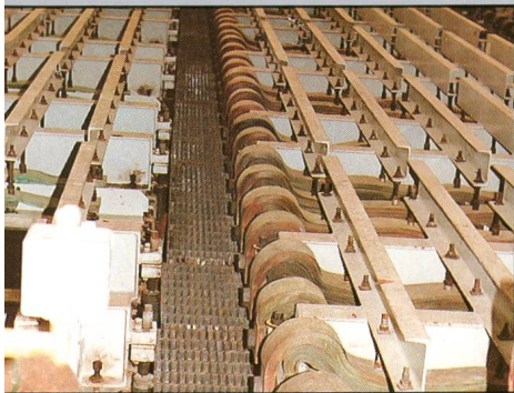
ELEKTROLYSE Dehnungsbänder mit pressgeschweißten Anschlussflächen, für die Einspeisung von Elektrolysezellen.
