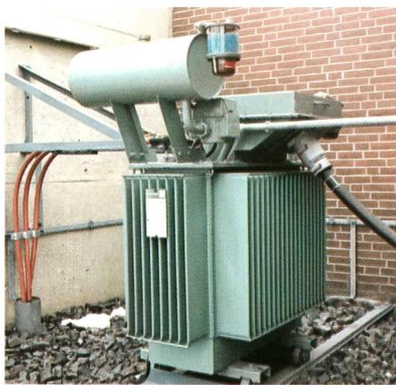
Das ist Verteiltrafo-Standard. Weltweit zehntausendfach bewährte Öltrafos in verschiedenen Ausführungs- und Anschlussvarianten. Leistungsbereich 50 bis 2500 kVA:
