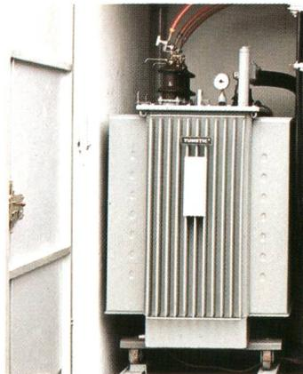
Bei Platzmangel, schwer zugänglichen Standorten und erhöhten Anforderungen an die Wartungsfreiheit ersetzt ein hermetisch geschlossener, elastischer Faltwellenkessel das Expansionsgefäß:
