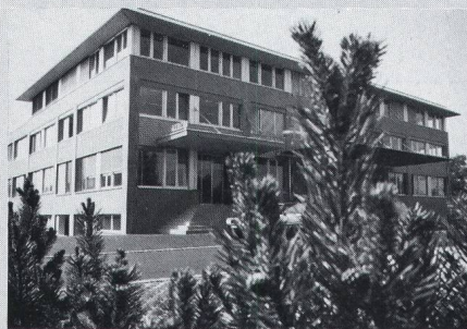
Neubau mit optimalen Arbeitsbedingungen
