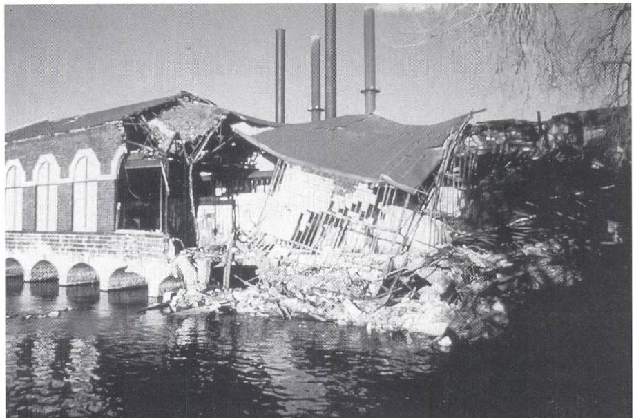
**Bild 1** Das Wasserkraftwerk St. Anthony Falls in Minneapolis, USA, nach dem Einsturz infolge Unterspülung
