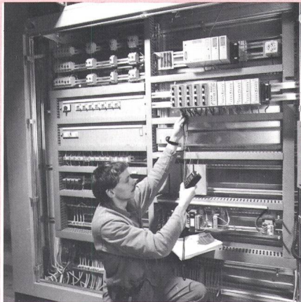
Arbeiten an einer Grossverteilanlage
