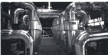
Au départ de la centrale nucléaire de Beznau, ces installations transmettent la chaleur rejetée au réseau de chauffage à distance Refuna.
