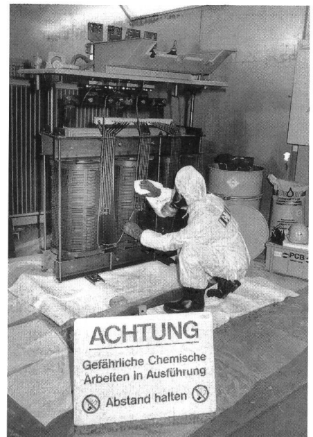
Bild 3 Die Dekontamination eines PCB-verseuchten Transformators erfordert ein äusserst sorgfältiges Vorgehen.
