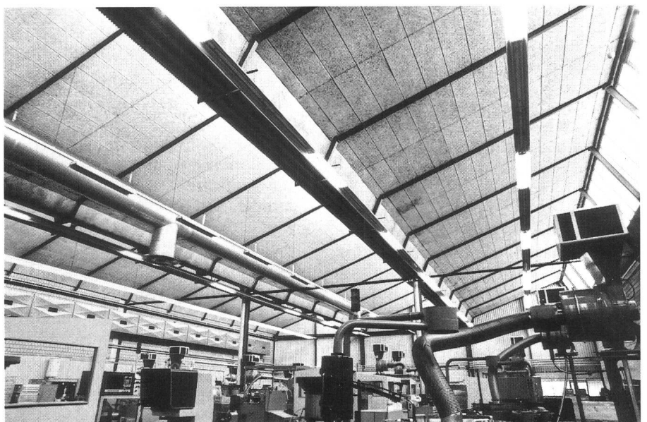
Bild 3 Flexibles Beleuchtungssystem für die Produktionshalle der SFS Presswerk Heerbrugg AG: Erster Rang in der Kategorie 2
