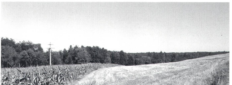
Bild 5 Mast mit Wald im Hintergrund
