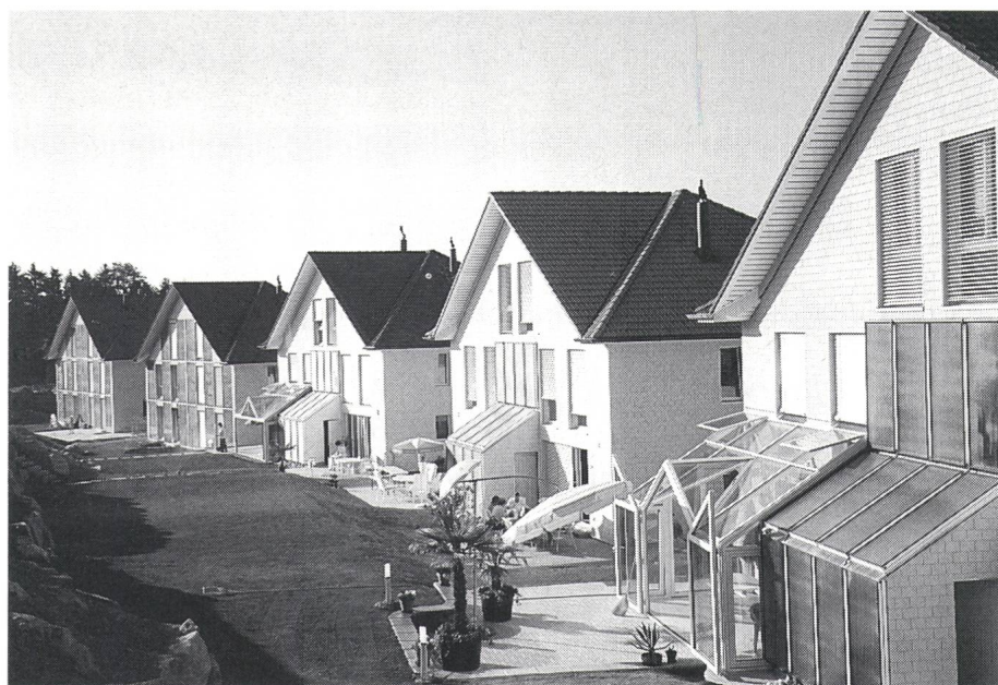
Bild 4 In Wädenswil ist eine Siedlung entstanden, von der vier Häuser in einem günstigen Winter allein durch Sonnenenergie beheizt werden sollen
