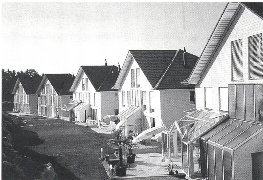
Bild 4 In Wädenswil ist eine Siedlung entstanden, von der vier Häuser in einem günstigen Winter allein durch Sonnenenergie beheizt werden sollen
