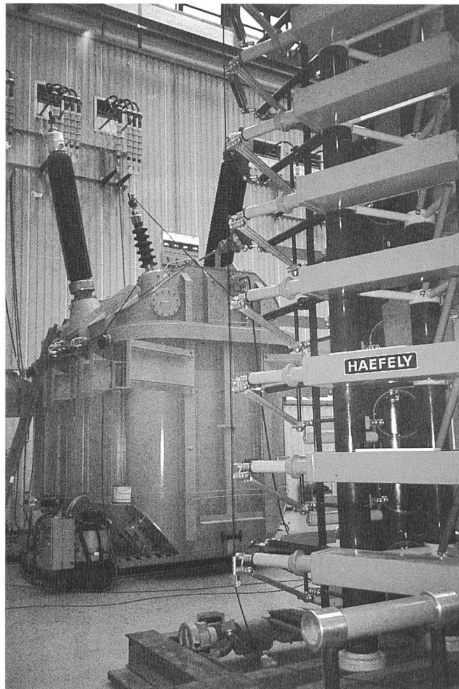
Hauptpol der 1000-MVA-Transformatorgruppe bei der Blitzstossprüfung
