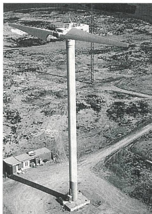
Strom für 940 Haushaltungen in Sardinien: Windenergieanlage von De Pretto-Escher Wyss
