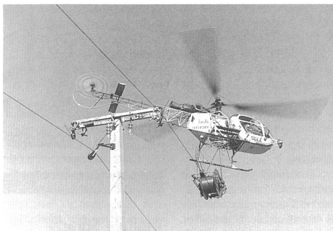
Anflug über Seilrolle, Kabel einfahren und sichern
