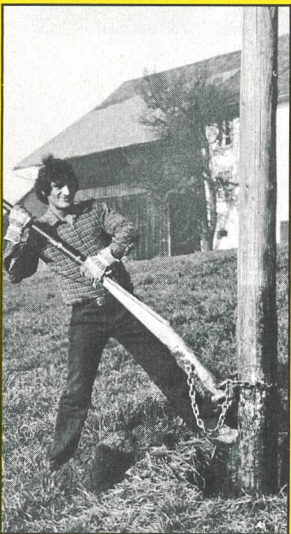
Nachimprägnierung von Holzmasten
